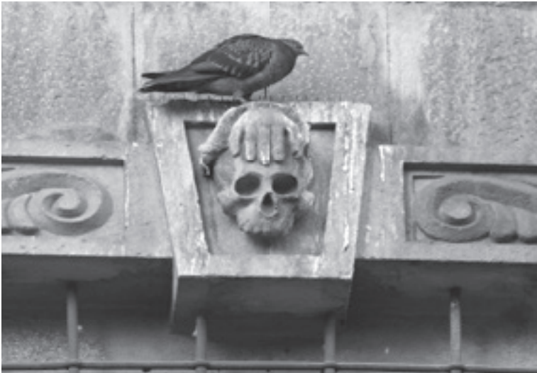
Fachada de la iglesia de San Francisco en La Paz. La calavera representa el estilo de vida austero, propio de los franciscanos. (Foto: Milton Eyzaguirre.)
